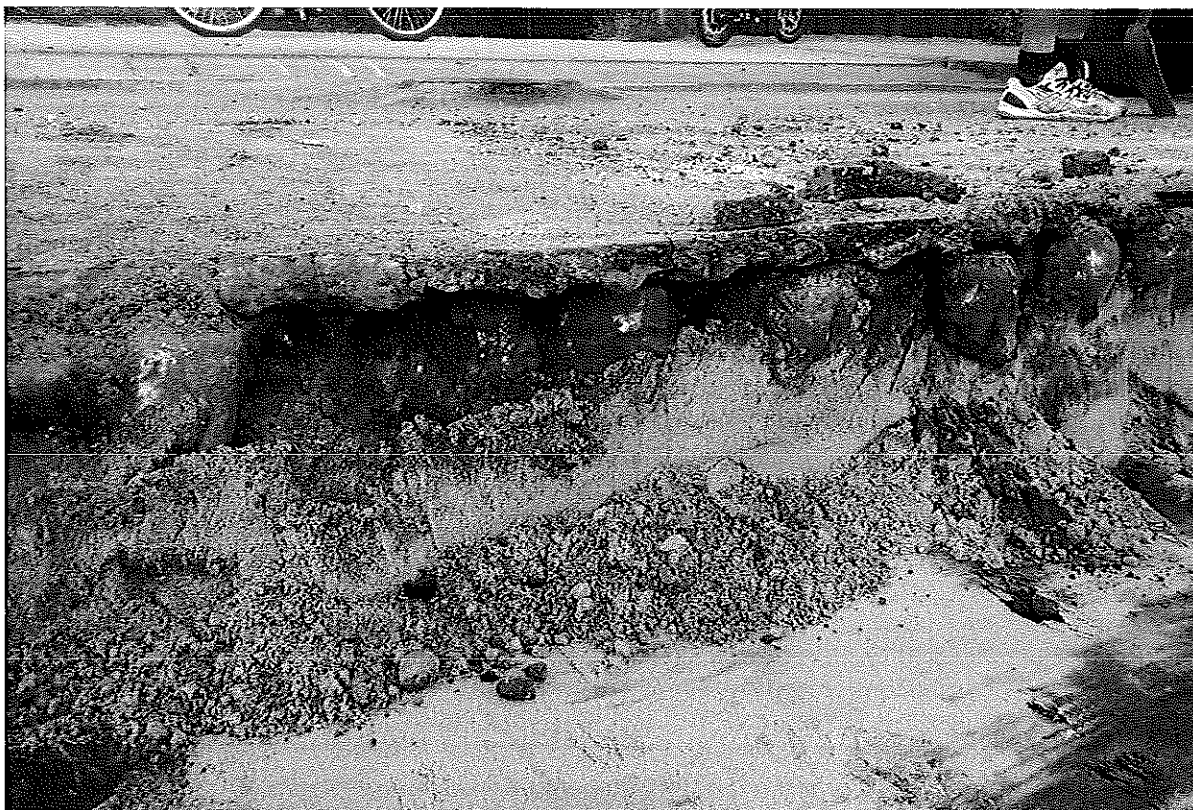
Zdjęcie nr 1 wykonane w trakcie remontu ulicy.
